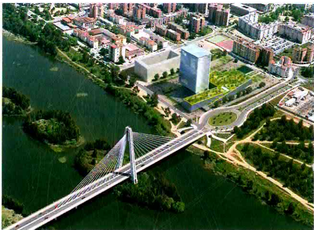
Proyecto para Caja Badajoz, en construcción.
